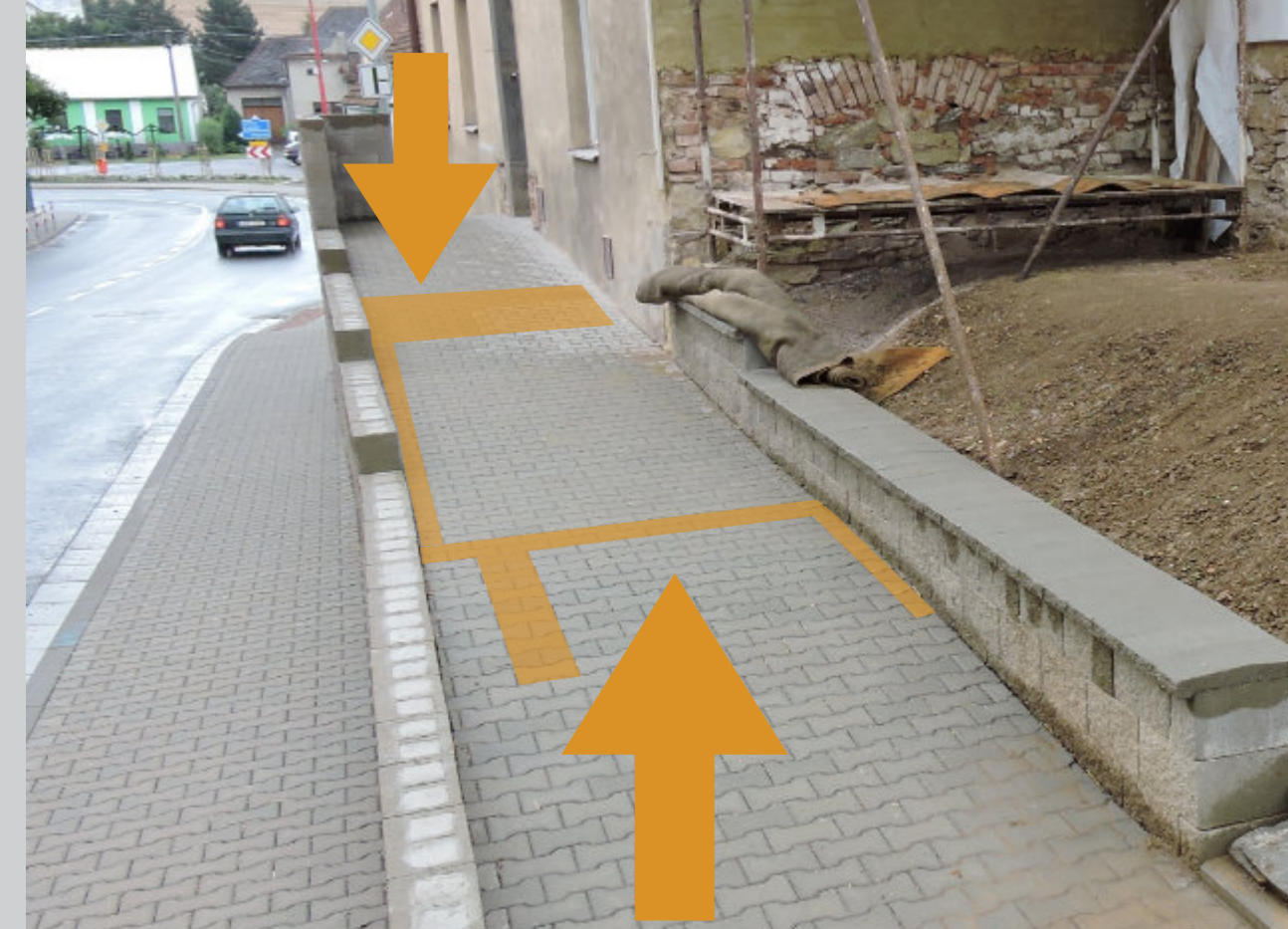
Současný stav - v dlažbě naznačen průběh zdiva domu
