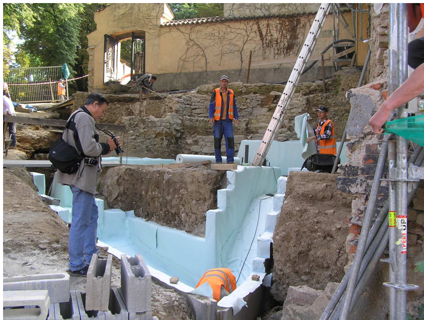
Příprava pro betonování základových pasů budoucího vstupního objektu muzea na dvorečku bývalé čajovny. foto René Klimeš 14. 8. 2013
