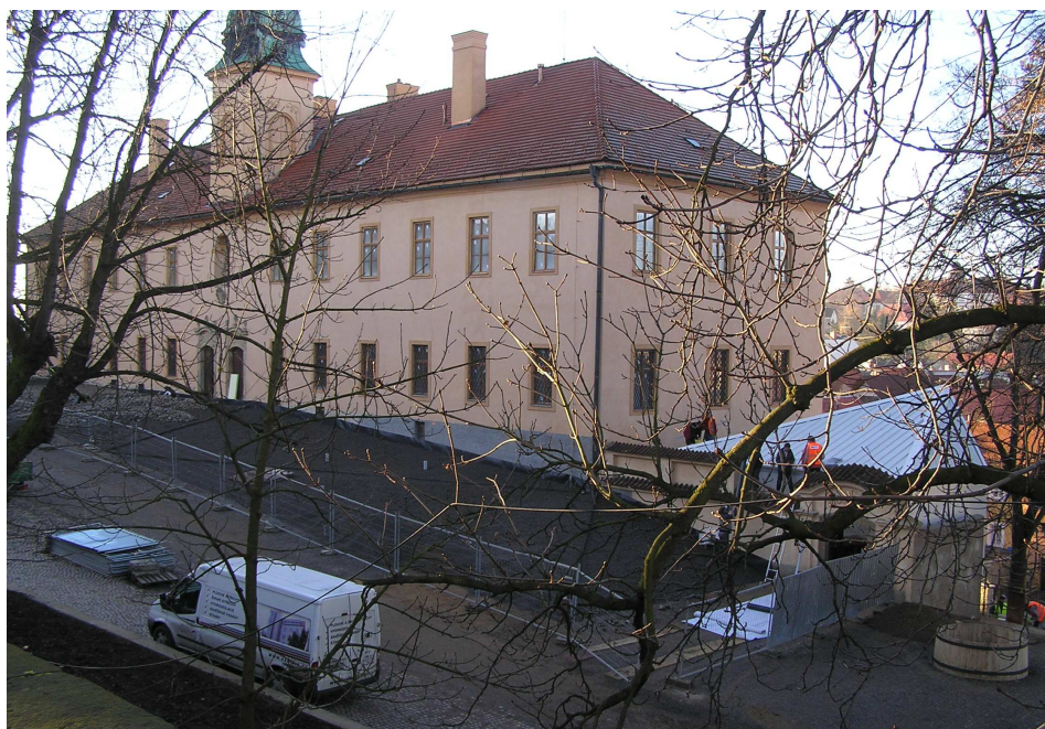
Vlevo suterénní ochranný objekt nad archeologickými nálezy, vpravo střecha budoucího vstupního foyer. foto René Klimeš 16. 12. 2013
